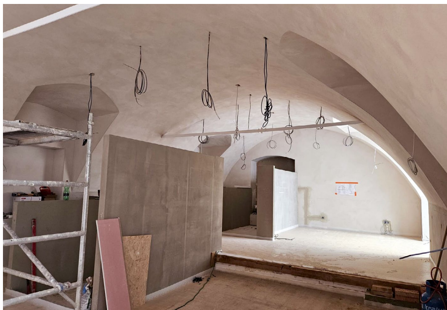
Stavba nové bezbariérové knihovny finišuje – foto: P. Havlová
